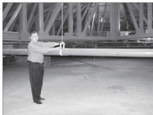
Percy Zamora, arquitecto del TSE, muestra el área donde se construirá el sétimo piso del edificio de La Torre. El acceso será por el sexto piso.
