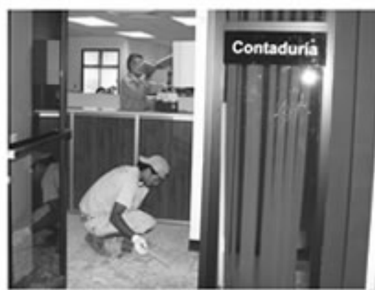
La reparación del piso se realizó en algunas áreas del tercer, cuarto y quinto piso del Edificio La Torre y en el segundo piso del Edificio Electoral.
