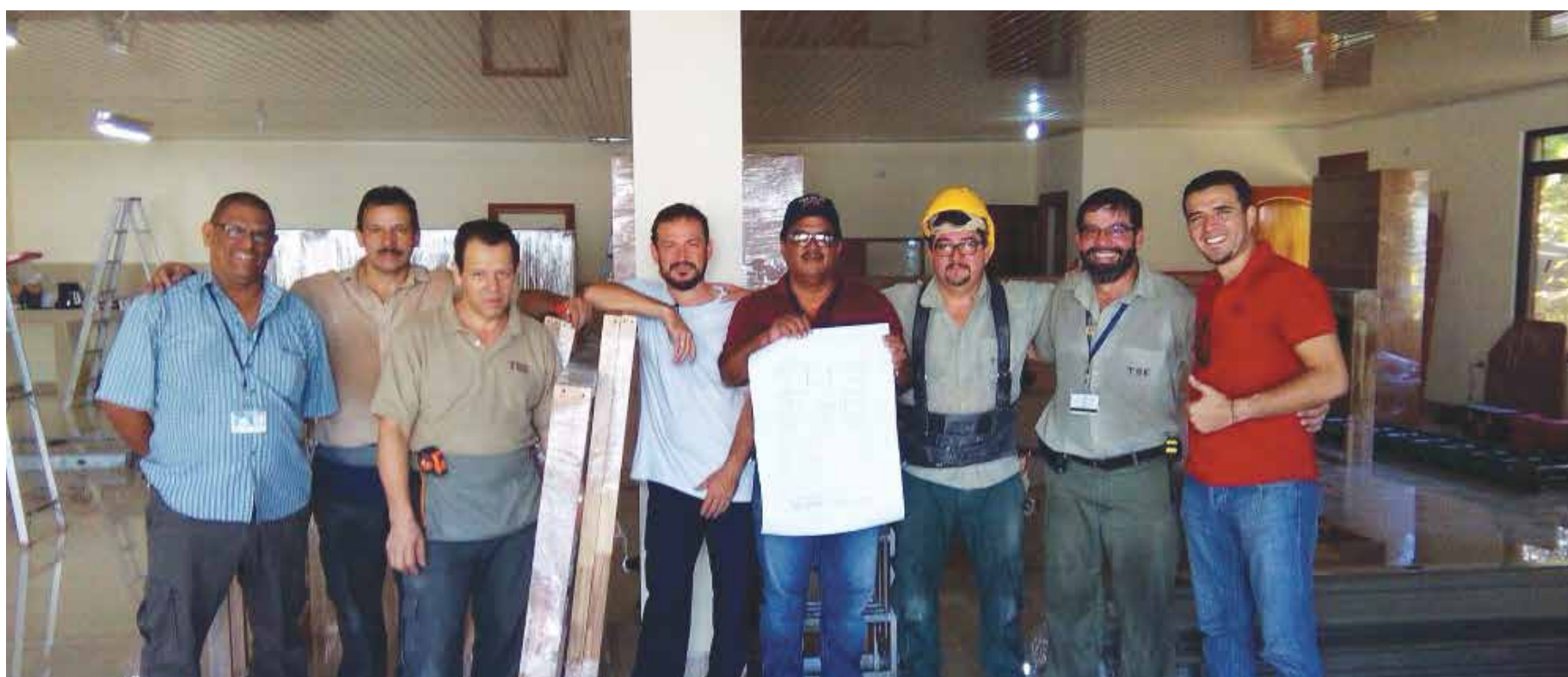
Parte del Equipo de artesanos del TSE durante la remodelación de la Oficina Regional Osa. Colaboró Jorge Solano
